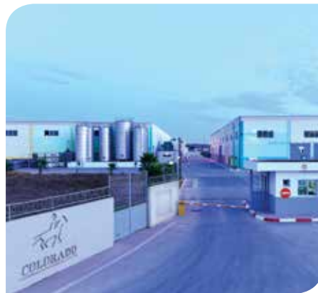
Site industriel Dar bouazza Casablanca
