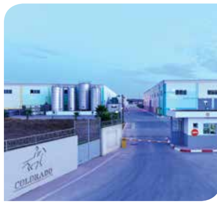
Site industriel Dar bouazza Casablanca
