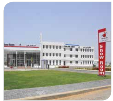
Plateforme Logistique Al Gharb Kénitra
