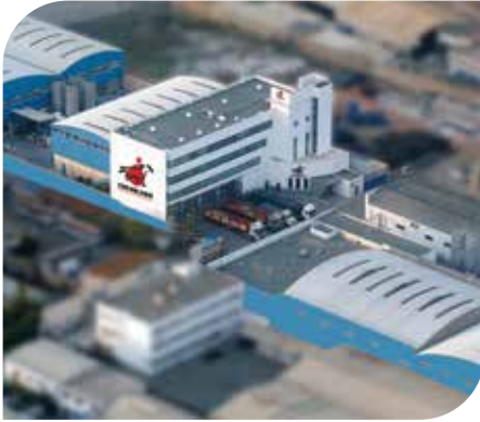
Usine et Administration Ain sebaa Casablanca
